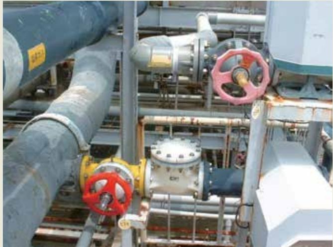
⌘ PVDF-Schwingen-Rückschlagklappe, die horizontal in einem Chemiewerk installiert wurde und seit mehr als 20 Jahren in Betrieb ist.
